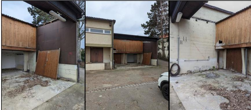
Der Bereich Abstellraum im EG ist Holzverkleidet. Darunter liegt im UG ein Lager und Gerätlager (s. Anlage 1). Die Dachabdeckung ist aus Eternitplatten.
