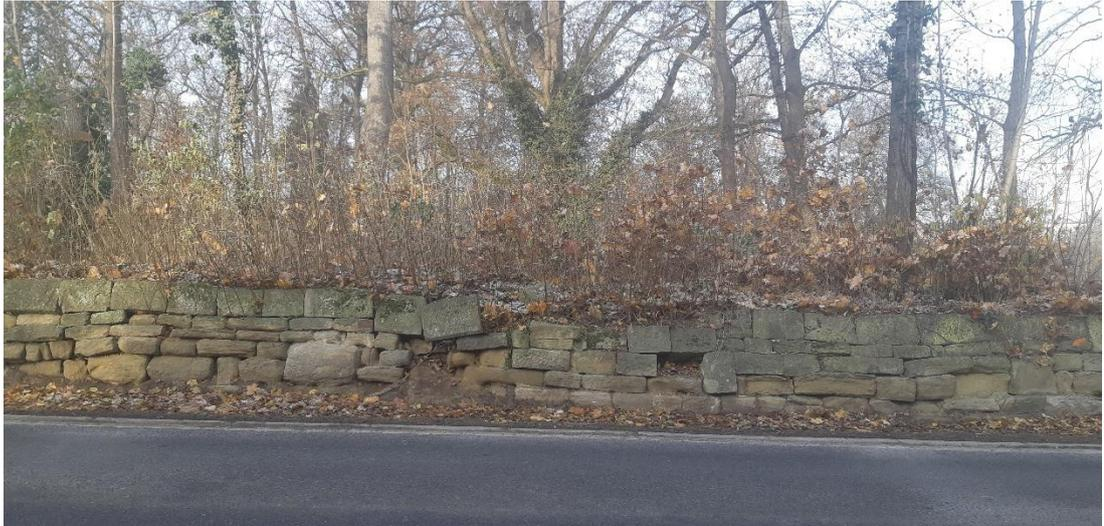
Abb. 28 *Naturstein-Wechselschichtmauerwerk aus der 2. Zeitschicht entlang der Schwieberdinger Straße, stark verwittert und ausgewaschen, Steine teilweise lose, Bewuchs über Mauerkrone*
