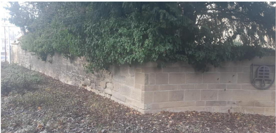
Abb. 27 *neu aufgebaute Mauer (neues Schichtmauerwerk) aus den 1980er Jahren am Haupteingang, im Hintergrund links die zugemauerte alte Toröffnung*
