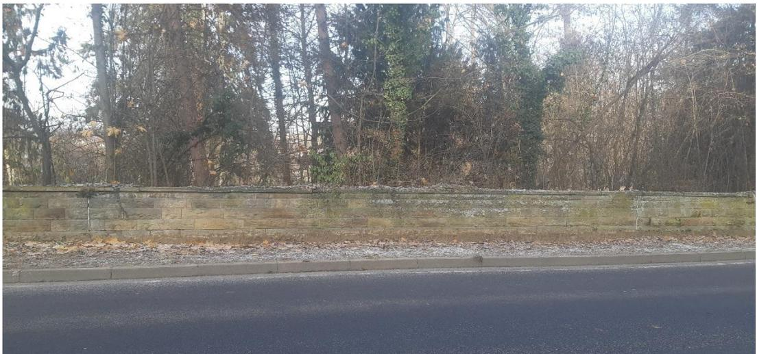
Abb. 29 *Betonmauer mit Natursteinverblendung aus den 1980er Jahren*
