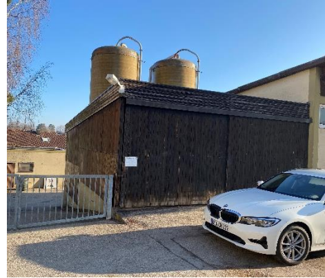
Foto 2: angebauter Schuppen, Südseite (Blick nach Norden)
