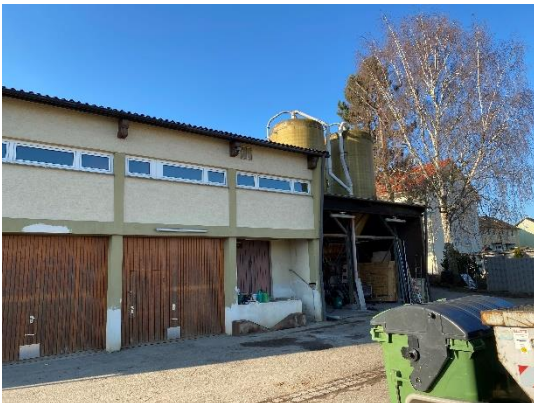
Foto 3: Büro- und Lagergebäude (Hauptgebäude), Nordseite (Blick nach Südwesten)
