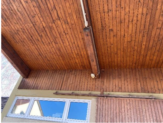
Foto 8: Hauptgebäude, Dachuntersicht Südseite (Blick nach Norden)
