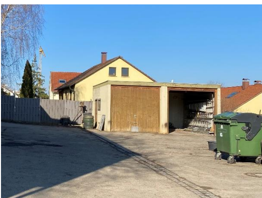
Foto 5: Doppelgarage (Blick nach Westen)
