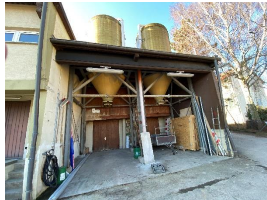
Foto 4: Siloanlage mit dahinter liegenden Garagen/Stauraum (Blick nach Süden)
