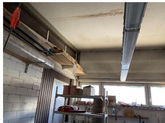
Foto 13: Hauptgebäude Garagenzeile, Innenansicht
