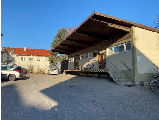
Foto 1: Büro- und Lagergebäude (Hauptgebäude), Südseite (Blick nach Nordwesten)
