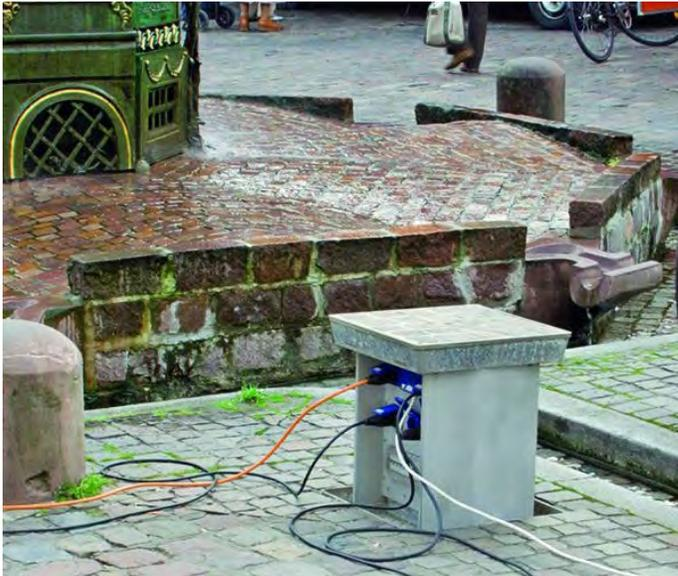
Senkelekrant mit Spindeltrieb
