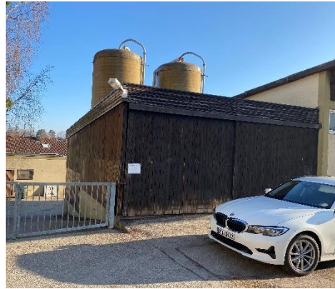
Foto 2: angebauter Schuppen, Südseite (Blick nach Norden)
