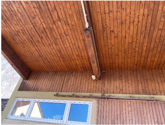
Foto 8: Hauptgebäude, Dachuntersicht Südseite (Blick nach Norden)
