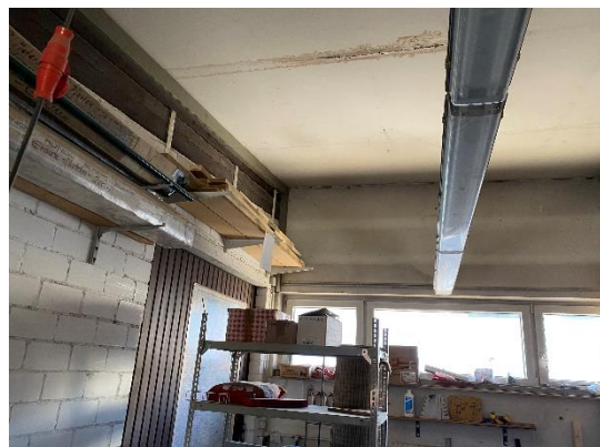
Foto 13: Hauptgebäude Garagenzeile, Innenansicht
