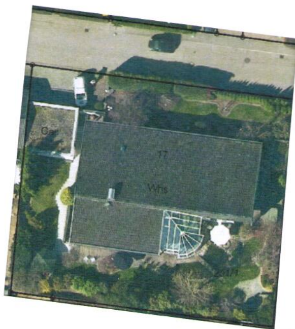
Grundstück Falkenstr. 17 (Flst. 251/1), Luftbild 2014
